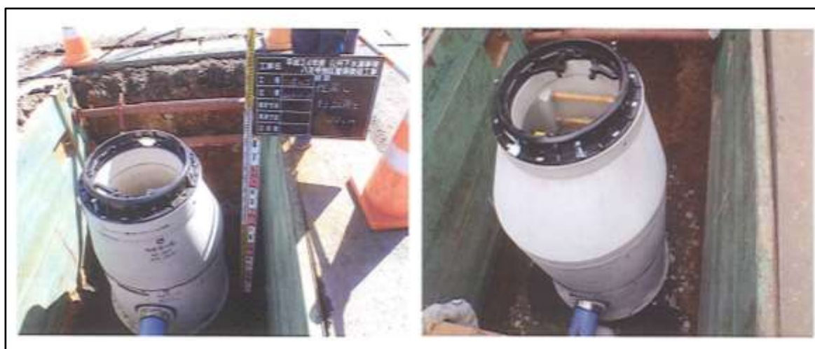
管渠・マンホール工事の様子
