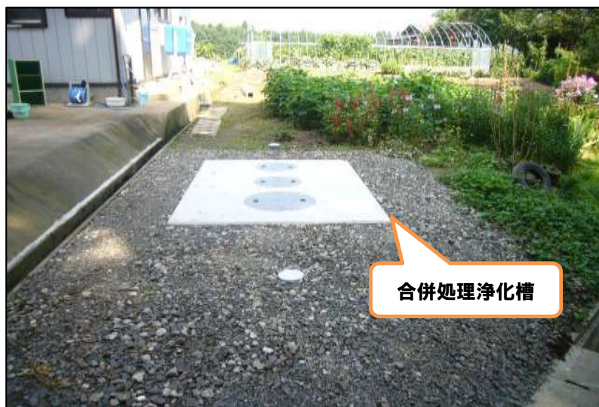
合併処理浄化槽の設置状況
