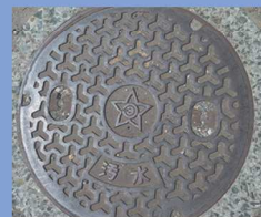
公共ます コンクリート製 （直径約40～50cm）
