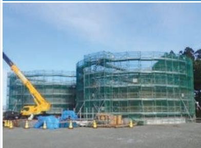
雄物川浄水場の配水池築造工事 (令和6年度繰越事業)
