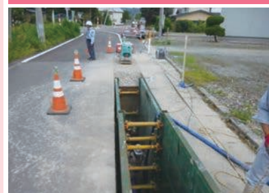
下水道管渠の築造工事
