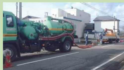
強力吸引車での作業のようす
