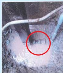
◀水抜き栓の不良による漏水
