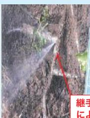
◀水道管の老朽化による地下漏水
