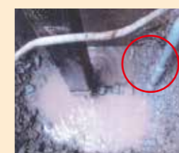
・水抜き栓の不良による漏水
