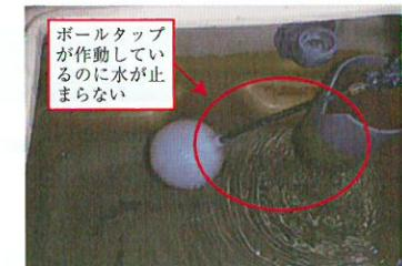
・水洗トイレのタンクへ給水されるボールタップの不具合による漏水
