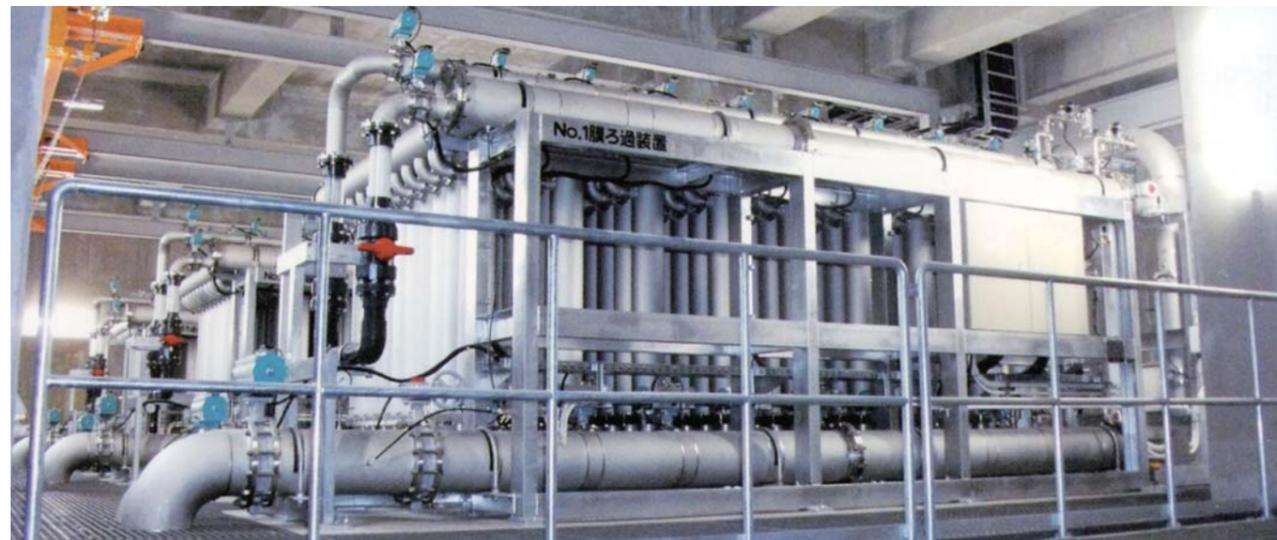
【膜ろ過設備】 セラミック膜により懸濁物質・凝集フロック・不溶化した鉄・マンガン・大腸菌・クリプト等を除去します。
