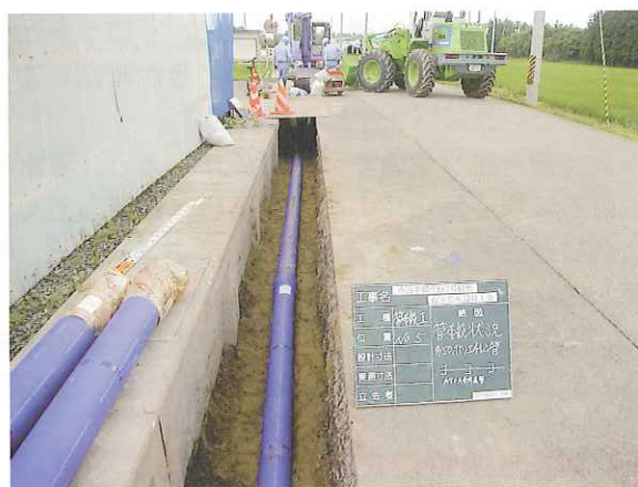
昨年度の布設工事の様子（安本字御所野地内）
