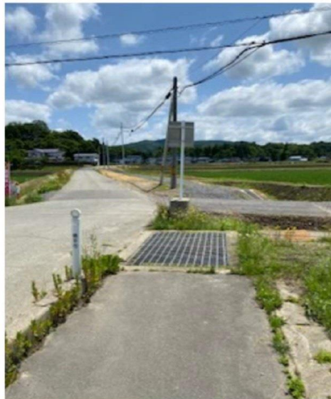
工業団地内の排水溝には蓋あり
