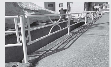
ハード事業を活用して修繕工事が行われたガードパイプ
