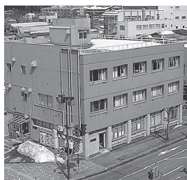
築51年が経過した水道庁舎
