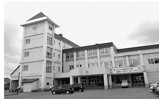
大規模改修工事が行われる浅舞小学校
