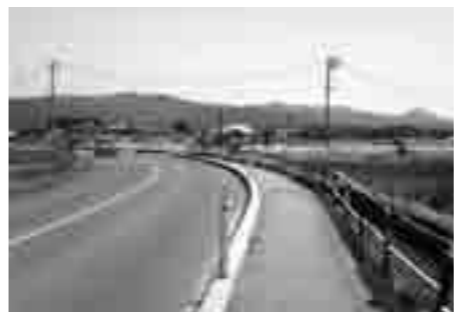
通学路としての安全確保が急がれる静町上小屋幹線
