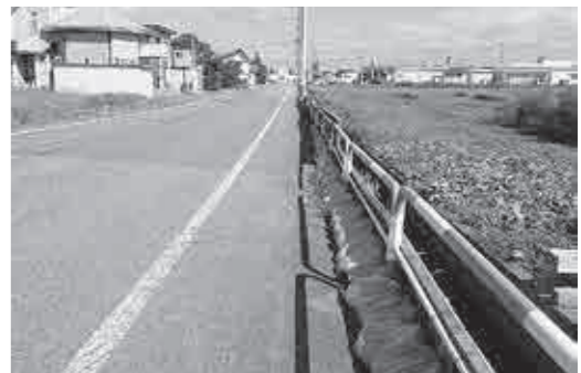
土のうを積んでいる荒沼地区
