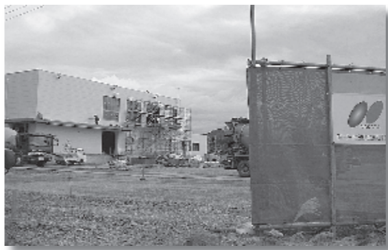
第二工業団地に建設中の新規企業
