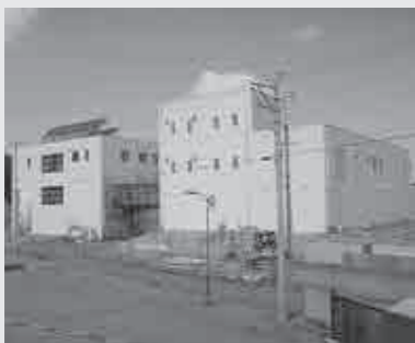
建設中の大沢第二浄水場
