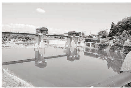
冬期間に取水が望まれる成瀬頭首工
