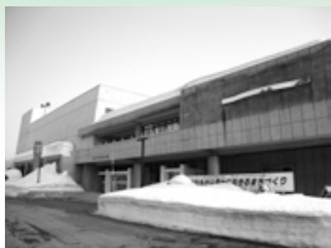
老朽化の進む市民会館
