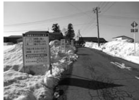
冬場に行われた水道工事
