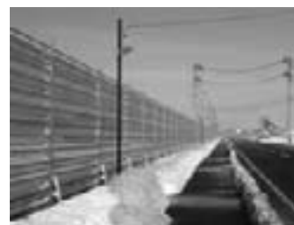
新たに設置された防雪柵と街路灯(横手明峰中通学路)
