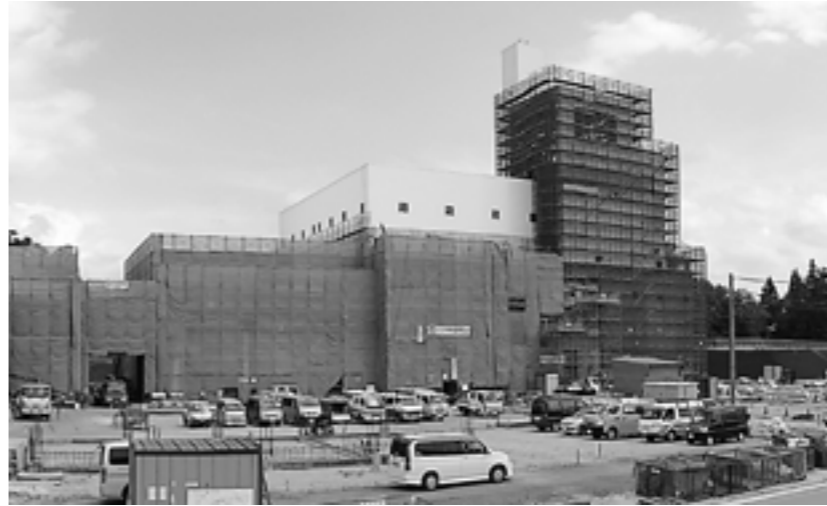
来春の本稼働に向けて工事が進む「クリーンプラザよこて」
