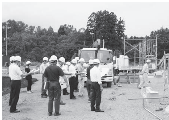
実験農場内に建設中の新管理棟を視察
