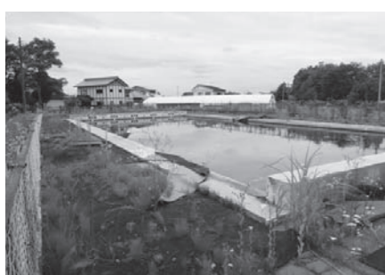
水を抜く前の旧横手西中学校プール
