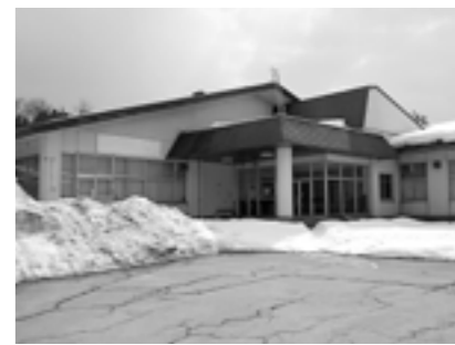
空き校舎となっている旧金沢中学校
