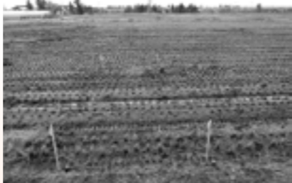
整備が始まった(仮称)横手北スマートインターチェンジ
