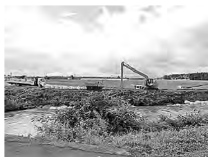
氾濫後の上溝川の様子（大森地域）
