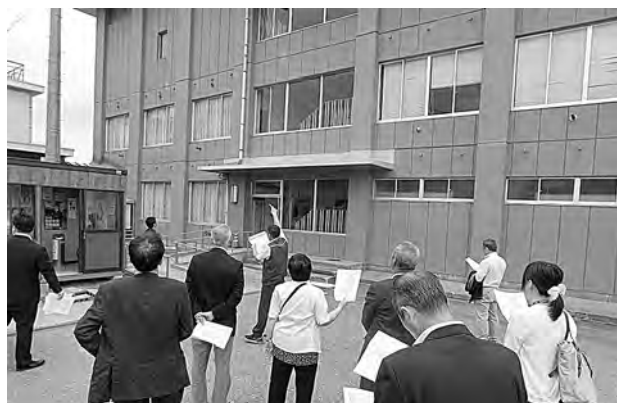
老朽化が進む雄物川庁舎
