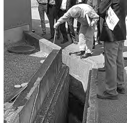
旭川町内の側溝の状況を調査
