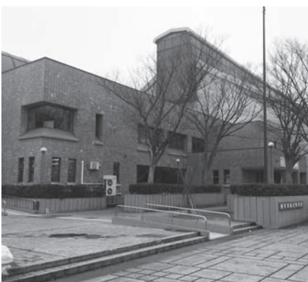
建設から40年近く経過した横手体育館
