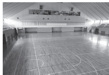
昭和53年度建築の横手体育館
