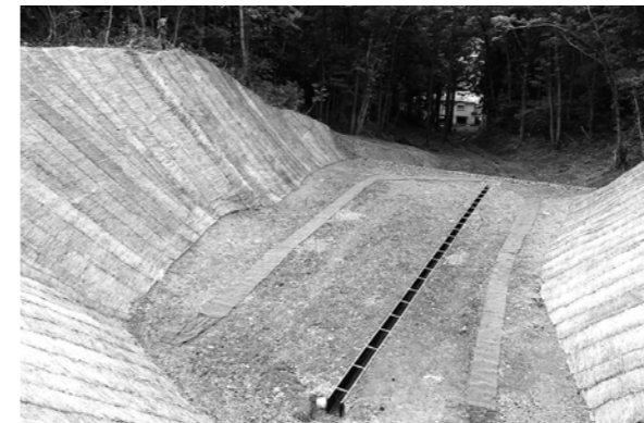
大雨災害復旧現場(八沢木地区)
