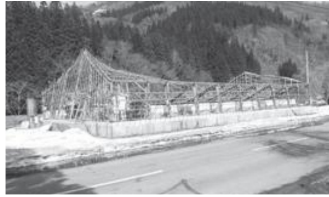
雪害により倒壊した特産品生産施設
