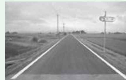
身近な生活道路の補修や消融雪施設の更新など、暮らしに密着した生活インフラの老朽化を解消します。
