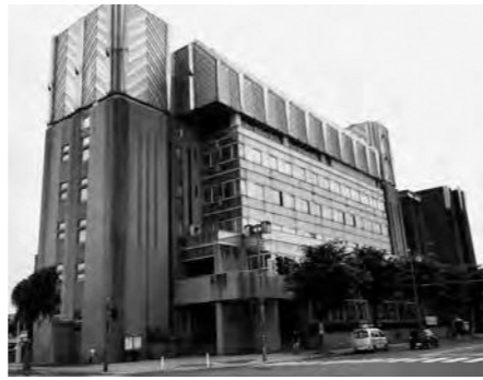
築30年を経過した横手市役所本庁舎
