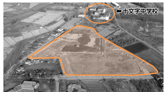
設置条例が可決した十文字地域統合小学校の広大な建設予定地（十五野地区）
