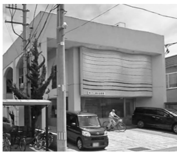
駐車場の狭さが課題となっている築34年の横手図書館
