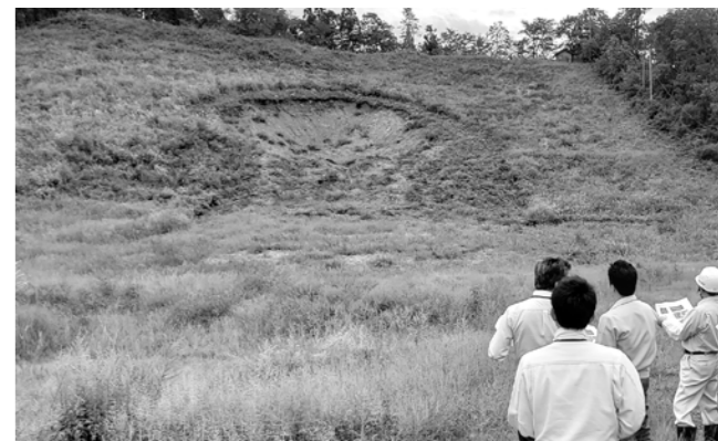
斜面が崩落した横手公園スキー場（9月10日視察）
