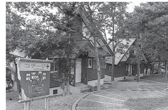
*ワーケーションを推進するため、Wi-Fi等の設備改修が行われるさくら荘コテージ
