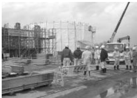
大雄配水場工事現場の視察
