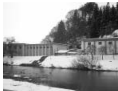
横手・上内町浄水場
