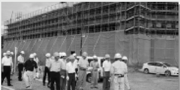
明峰中学校工事の進捗状況を確認
