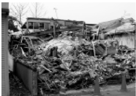
十文字町曙町の倒壊家屋
