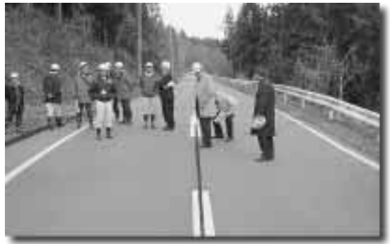
地滑りが発生した箇所を視察（大森地域）
