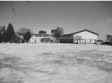
旧館合小学校敷地
