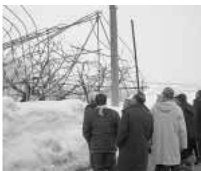
豪雪により破損したパイプハウス
