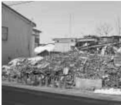
倒壊した空き家
