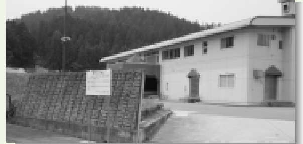
注意喚起の看板が設置された大沢浄水場
