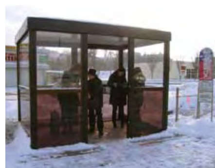
完成した高速バスの停留所施設
