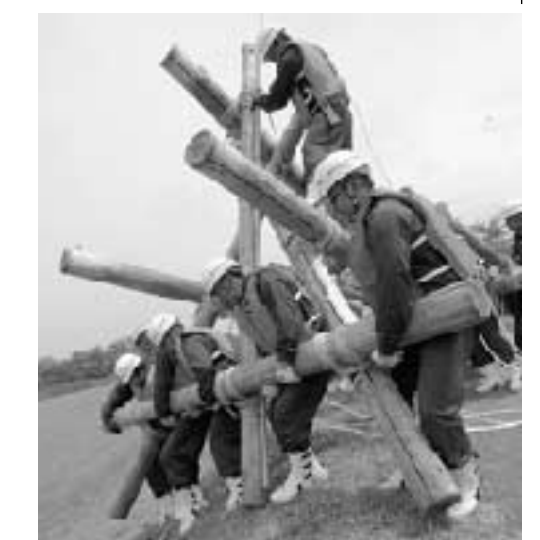
大雄消防団は17本の丸太を縄で組む川倉工法を実施
