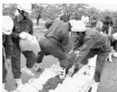
迅速かつ確実に工法に取り組む消防団員(積み土のう工法を行う山内消防団)
