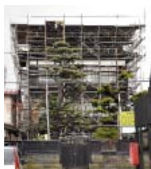
昨年行われた改修工事の様子
