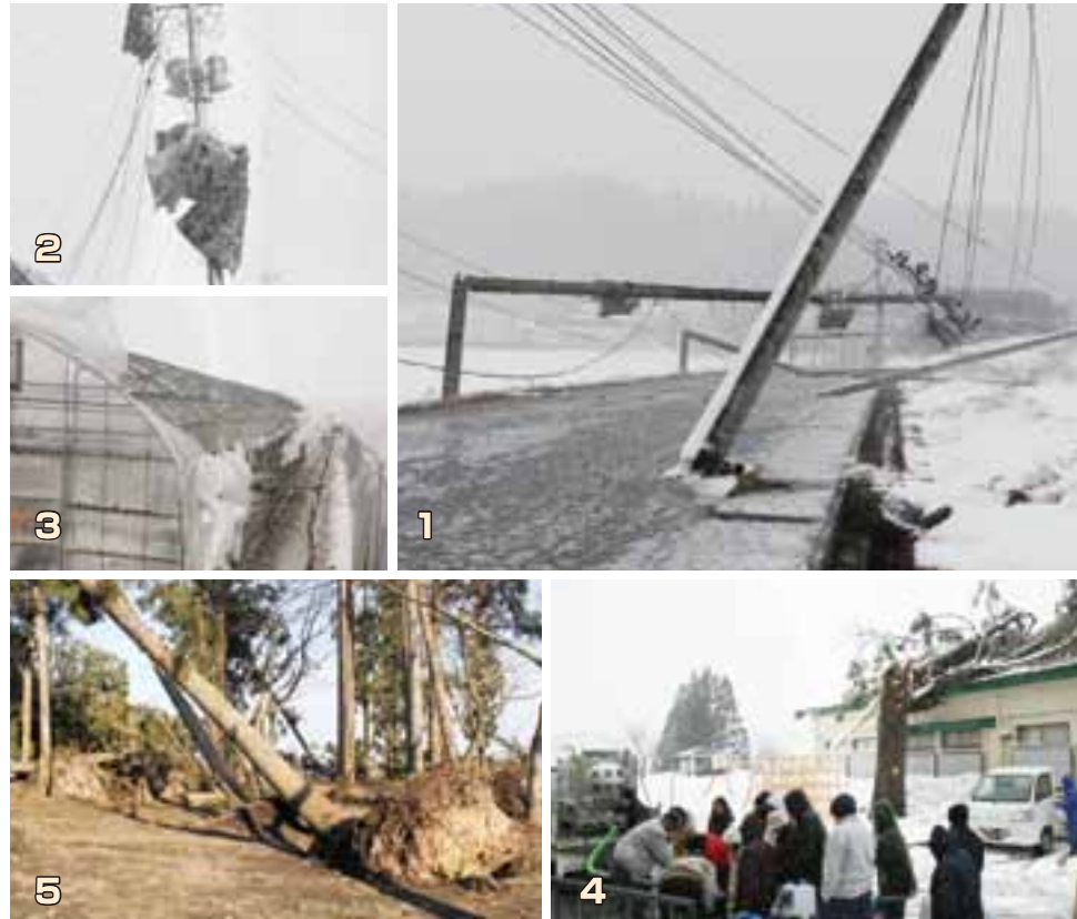
1_大森地域の市道をふさぐ電柱 2_市内のいたるところで送電線に飛来物が絡まる被害が発生 3_ビニールハウスなど農業用施設にも大きな被害 4_大沢保育所前で行われた給水作業 5_大木も根こそぎ倒されるほどの暴風が吹き荒れる(雄物川地域)
