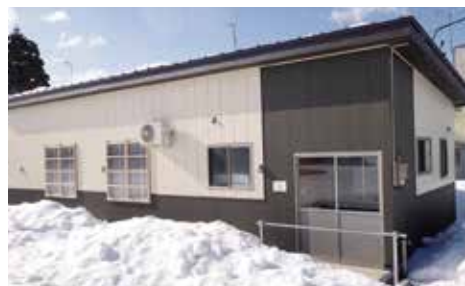
◎中島町内会館（雄物川）
