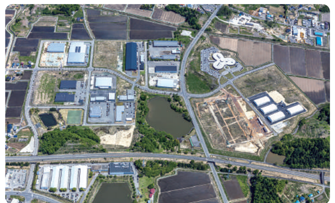
横手第二工業団地
