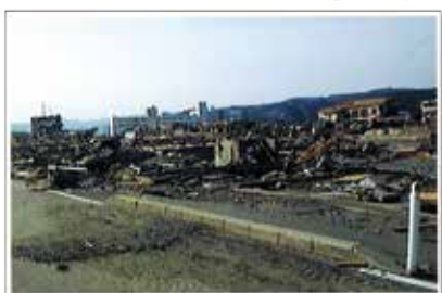
▼津波がひいた後の南三陸町の様子
