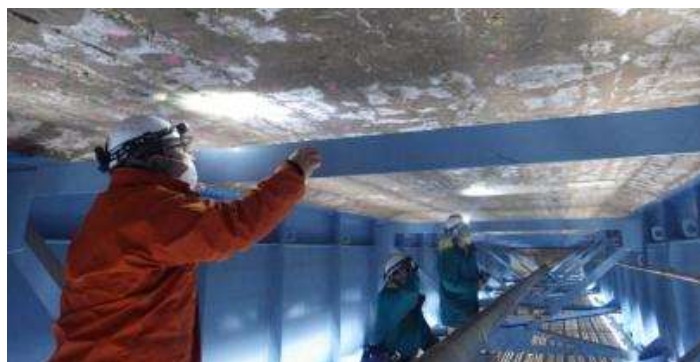
橋りょう補修工事のひび割れ調査
