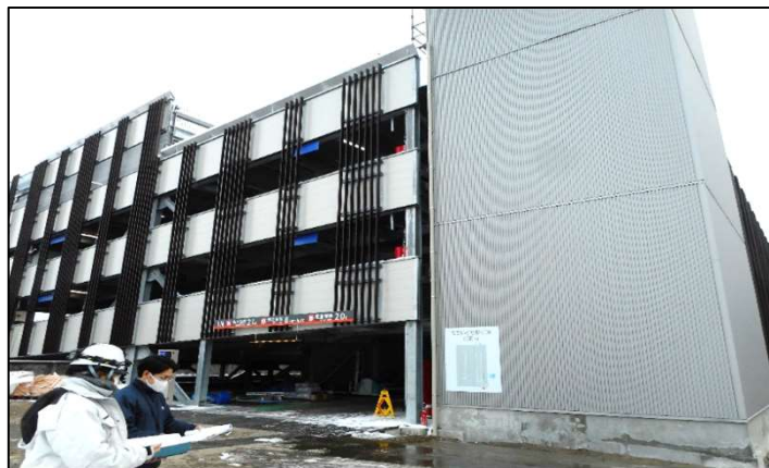
駅前新公共施設建設に伴う駐車場立体工事の進捗状況確認
