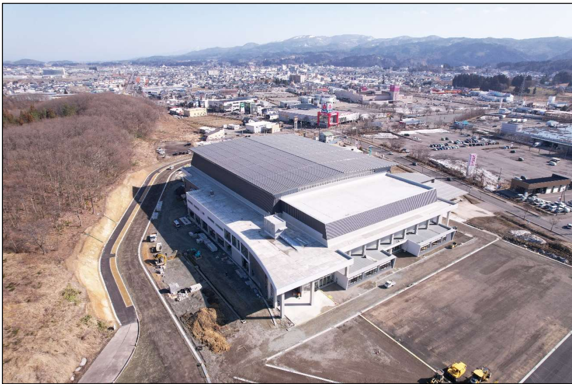
横手体育館建設工事（2026年4月現在）
