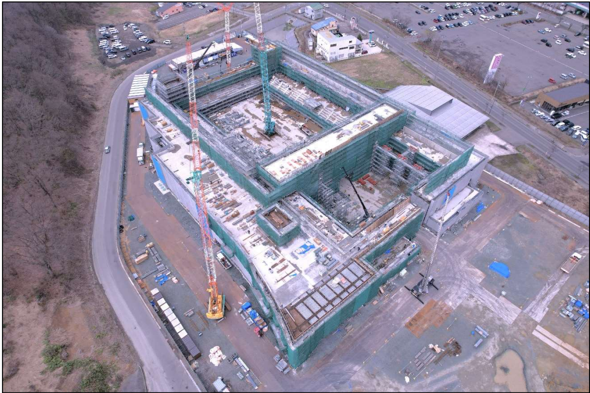
横手体育館建設工事（2025年4月現在）
