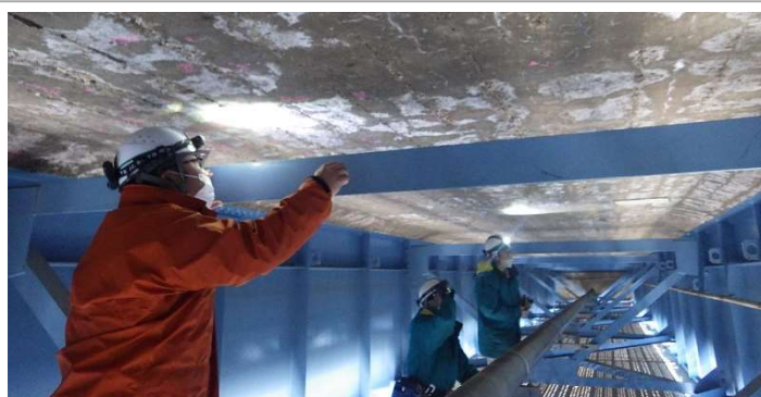
橋りょう補修工事のひび割れ調査
