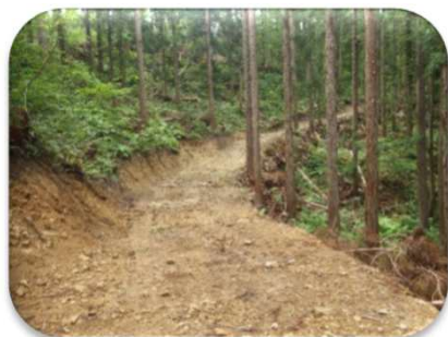
増田町狙半内地区の森林作業道
