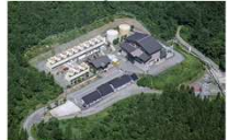
上の岱 地熱発電所
