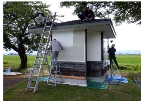
大雄運動公園屋外トイレ塗装
