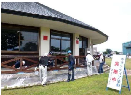
ふれあいホールの手すり塗装
