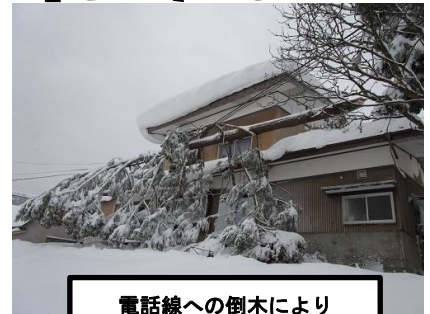
電話線への倒木により危険な状態に【土淵区】
