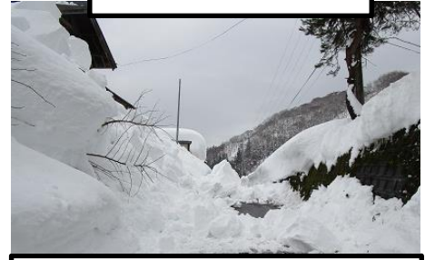
雪壁崩落により塞がれた市道【上平野沢区】
