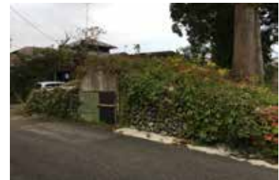
旧平鹿郡立農事講習所地下冷蔵庫
