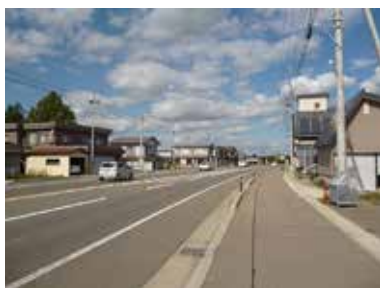
拡幅された国道 13 号
