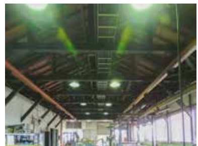
工場棟D内部
