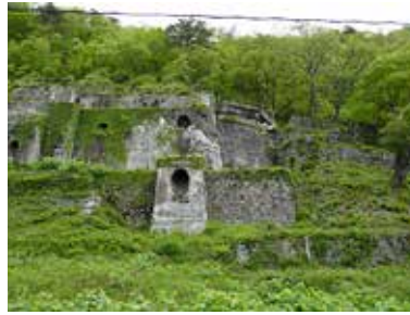
旧真人発電所水槽施設
