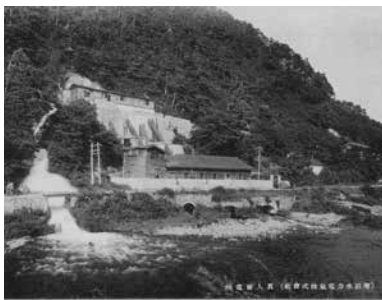
増田水電真人発電所（昭和10年頃）
