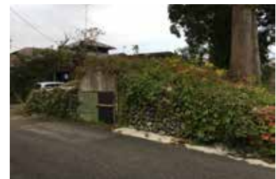
旧平鹿郡立農事講習所地下冷蔵庫
